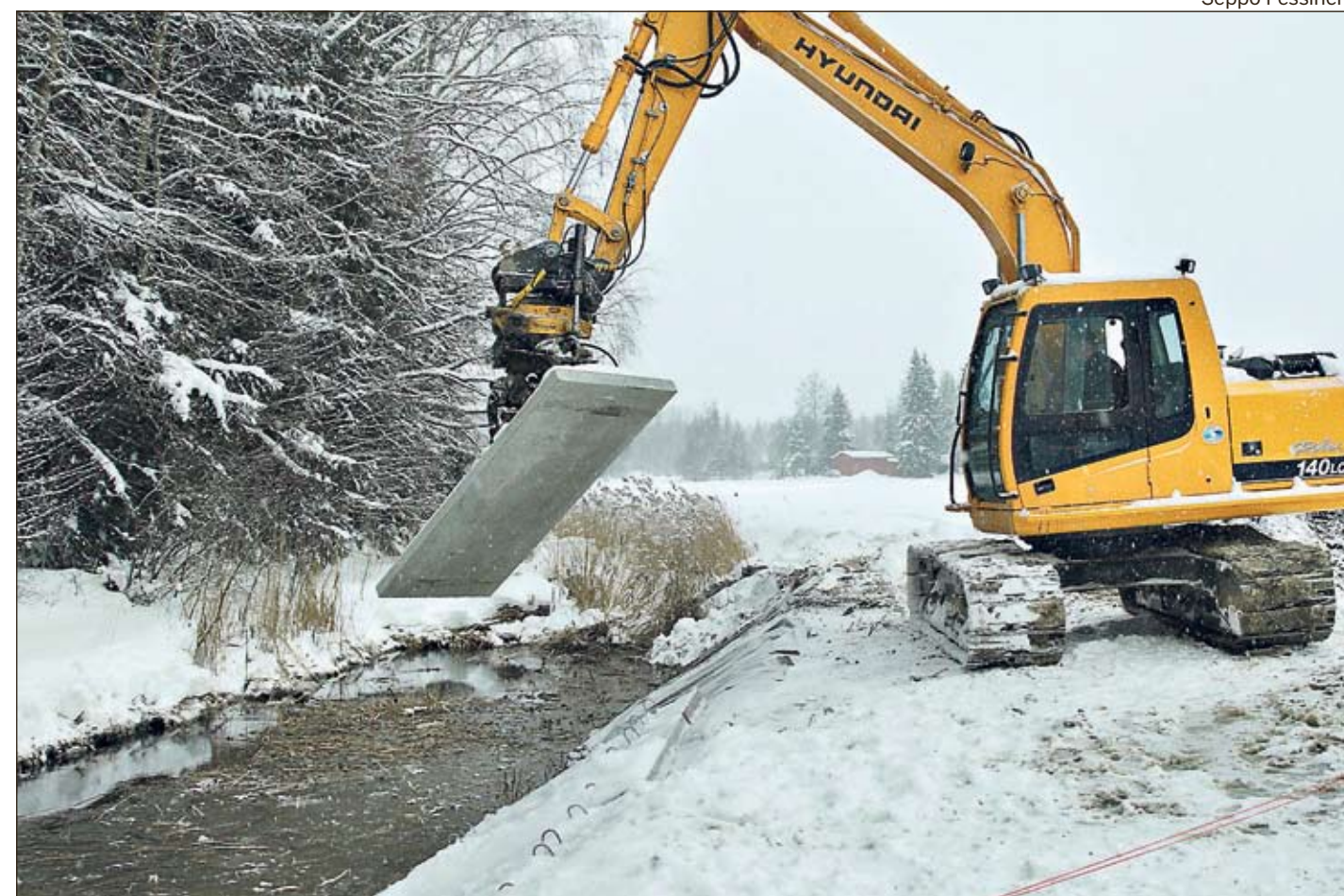
Heinijoen joentörmässä kokeillaan kuinka betoninen eroosiosuojalaatta kestää ja pysyy paikallaan vesimassojen painaissa.
